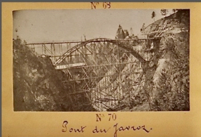
Sous le pont métallique du Javroz inauguré en 1881, on aperçoit le pont en bois de 1854.
