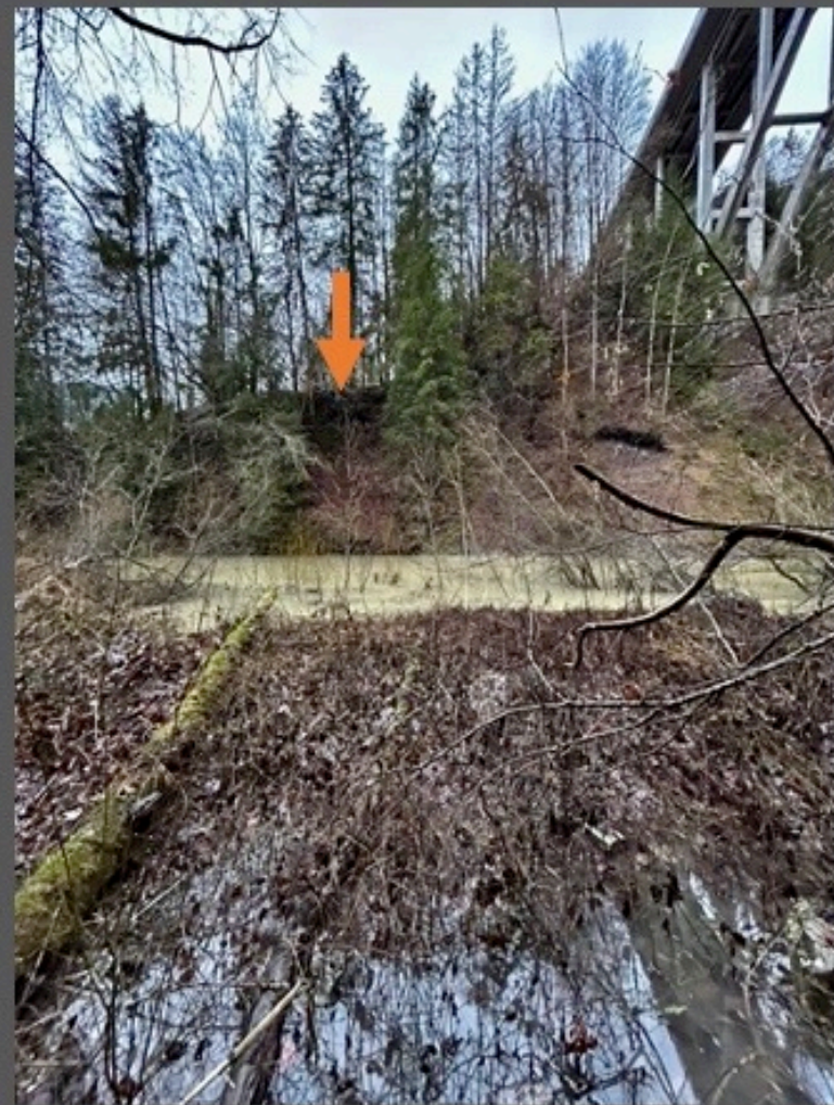
L'éperon rocheux et la culée de la rive droite sur lequel s'appuyait de ce côté le pont de 1854
