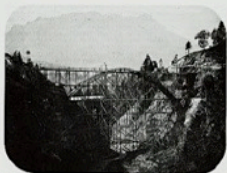
Construction de pont métallique de jumeaux sur la route Bulle-Boltigen, par Louis Charney (1880). Image éditée par l'Administration suisse des ponts pour le régime fédéral suisse. L'édition de Georges Pythou en français. Collection Marie Catherine Rime.
