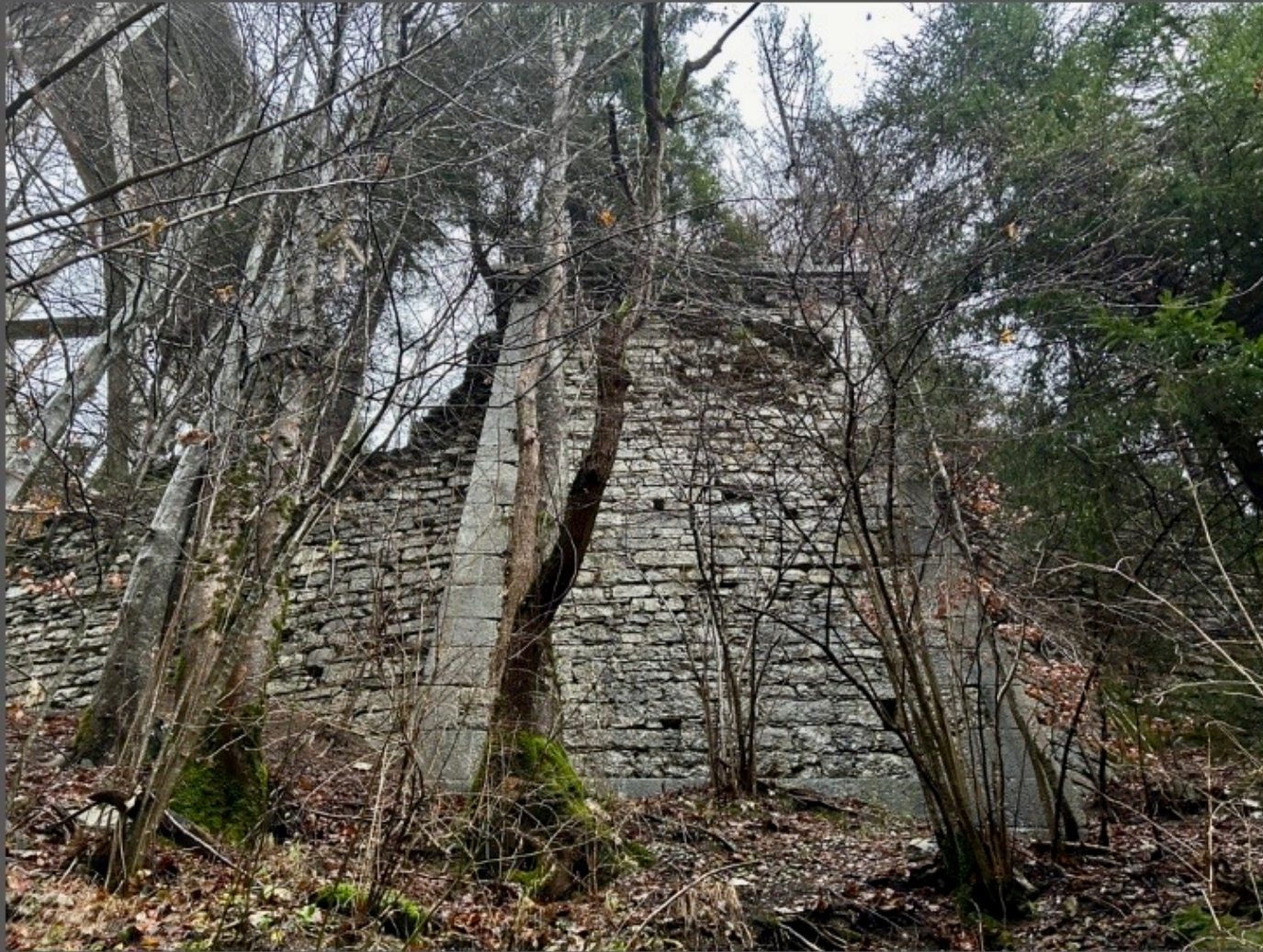
Vue des rives du Javroz, en hiver, la culée Est, rive gauche, bien conservée, est impressionnante (photo prise le 12.12.2023)
